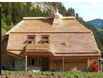
Toiture d'un chalet en tavillons. Image : Association Romande des Tavillonneurs
